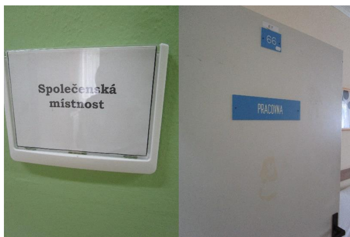
Obr. č. 1: Různé označení stejných dveří způsobem nevyhovujícím pro osoby se zdravotním postižením
