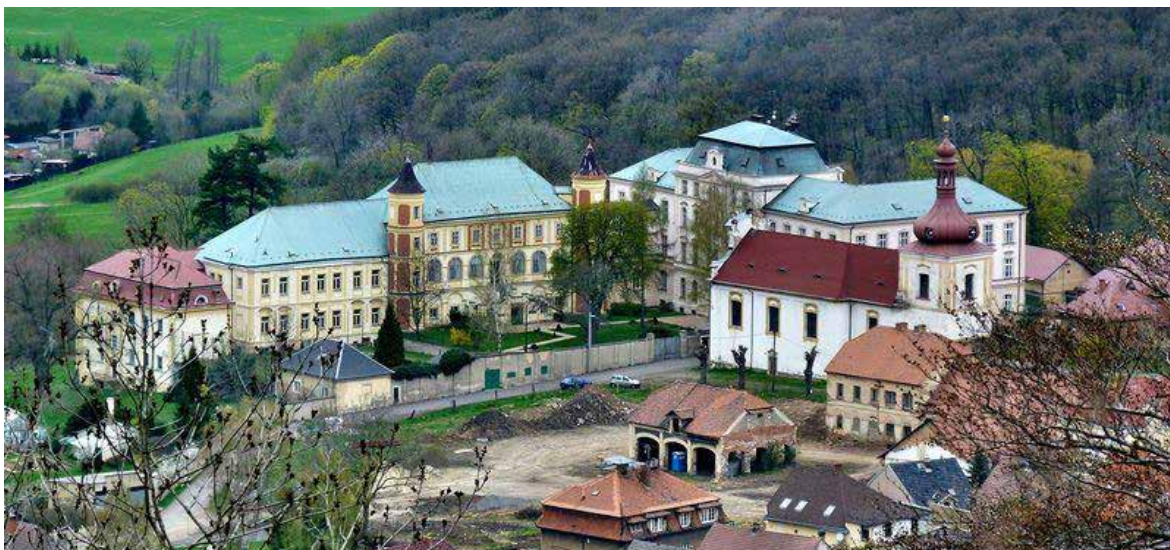
Dětský domov se školou a výchovný ústav Kostomlaty pod Milešovkou (zdroj: https://www.hrady.cz/index.php?OID=3313 & PARAM=2 )
