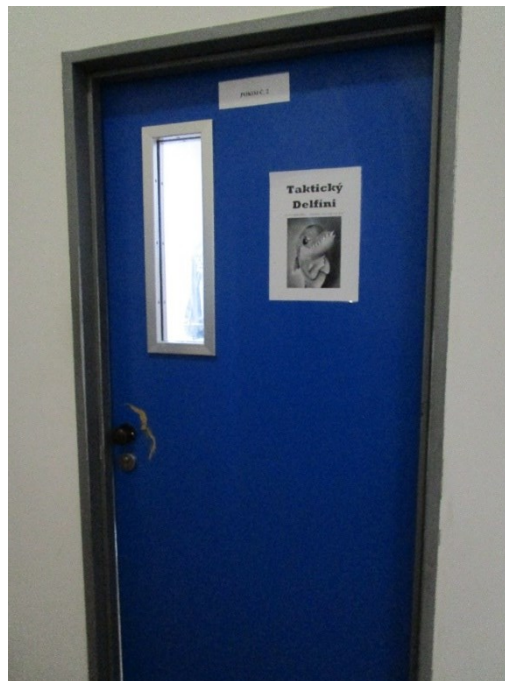
Obrázek 8 – průzor ve dveřích v budově tzv. Fary
