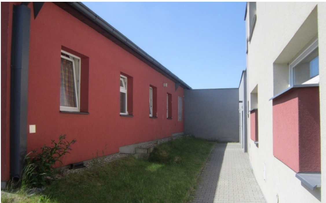
Obrázek 2: Ukázka zdi ohraničující areál a okapů, které jsou upraveny tak, aby po nich nebylo možno vyšplhat na střechu.
