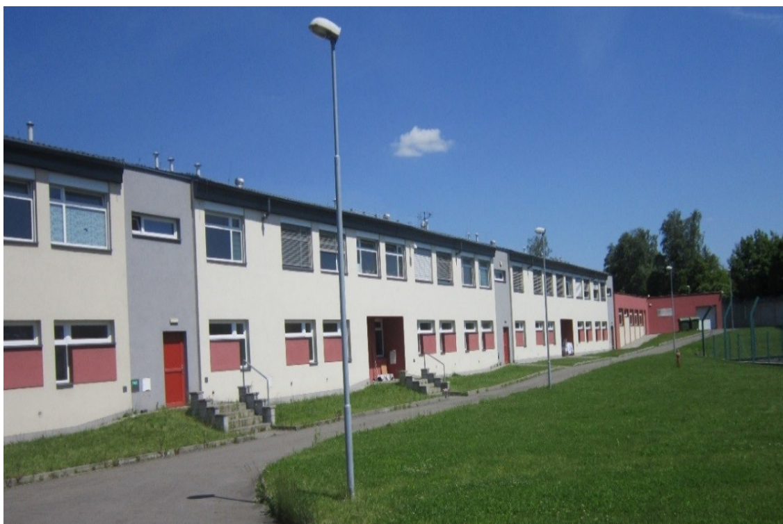
Obrázek 1: Pohled ze dvora na ubytovací část oddělení.
