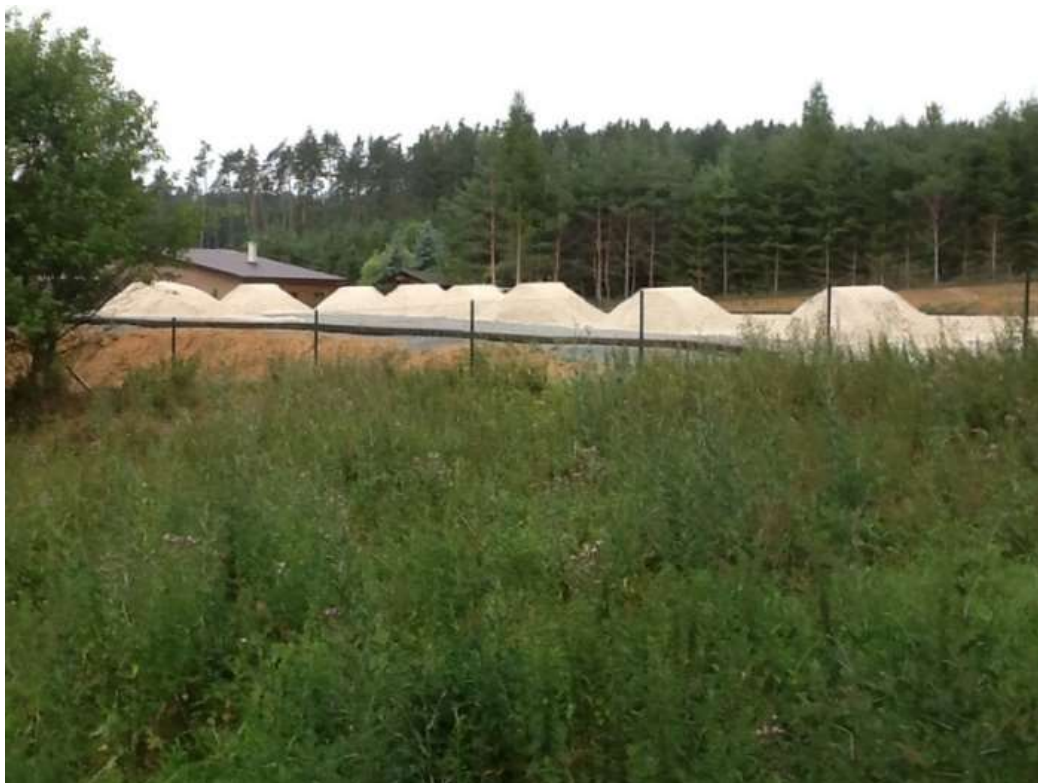
Foto č. 2 - složené haldy písků a štěrkové lože, datum pořízení dne 19. 7. 2019, založeno ve spisu stavebního úřadu.
