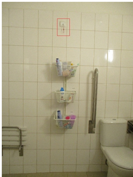
Obr. 5 Signalizace v koupelně klientů
