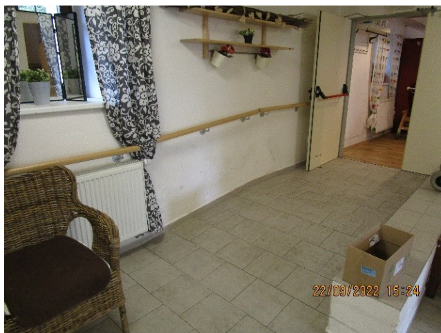
Obr. 1: Chodba v přízemí budovy
