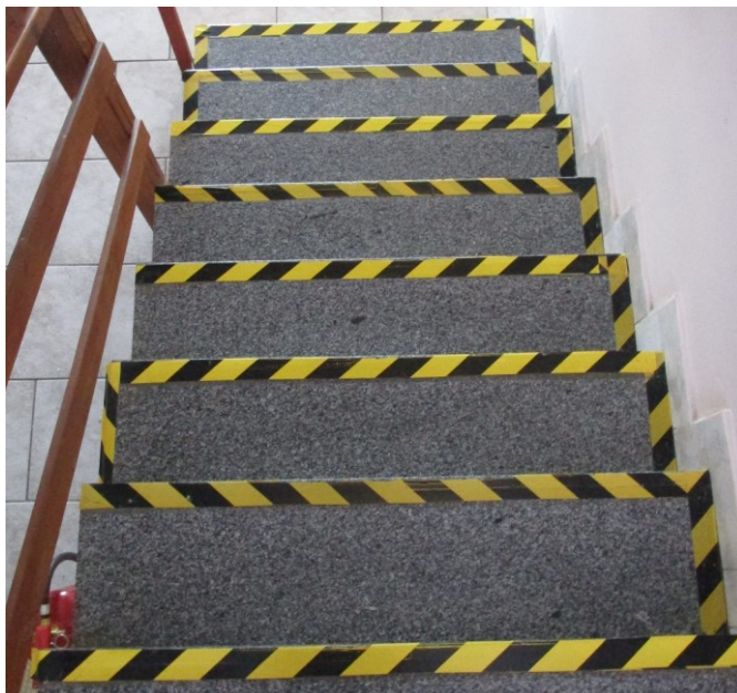
Obr. 1: Schodiště z prvního patra do přízemí
