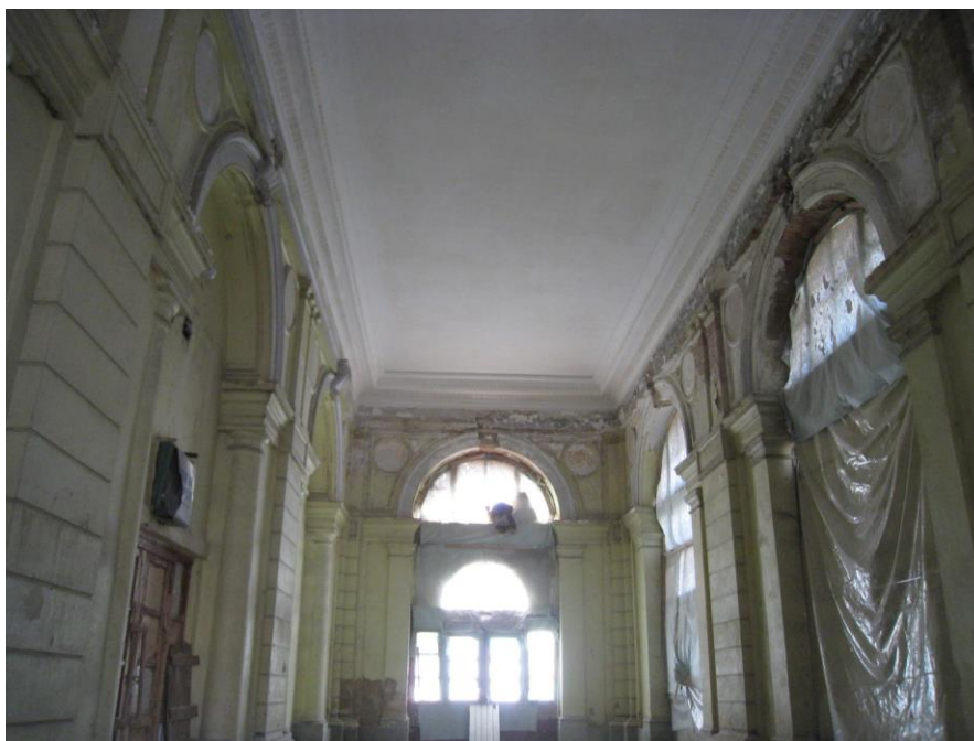
Obrázek č. 4 - opravený strop ve vstupní části nádražní budovy.
