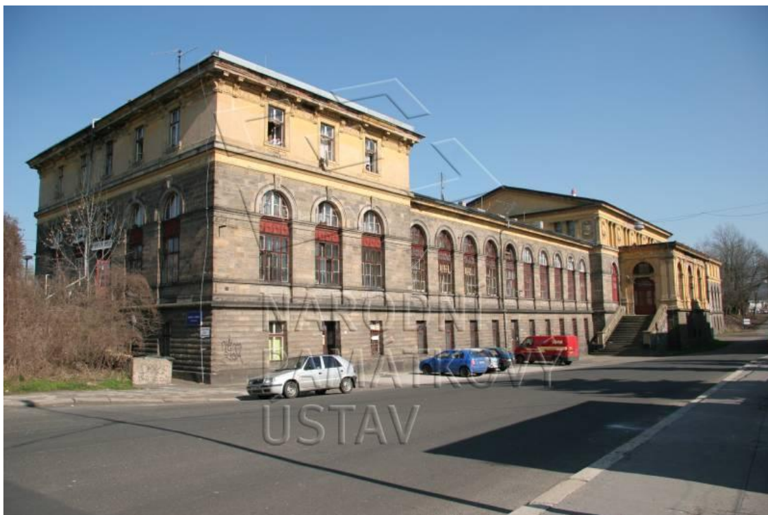
Obrázek č. 1 - objekt nádražní budovy čp. 362, celkový pohled z ulice 17. listopadu, Děčín.
